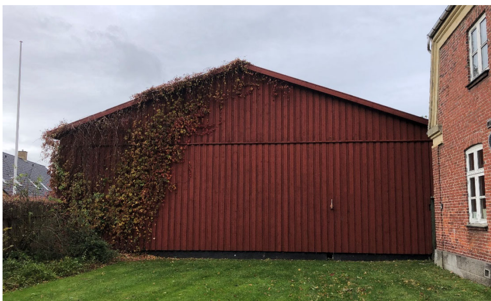
Den eksisterende ladebygning, som må nedrives og genopføres som en ny og moderne træbygning med samme placering og rumlige volumen som hidtil.
